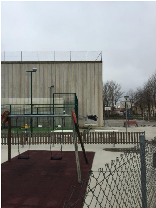
Vista desde la carretera de Celada del parque infantil, la trasera de la pared izquierda del frontón y la pista de minibasket
