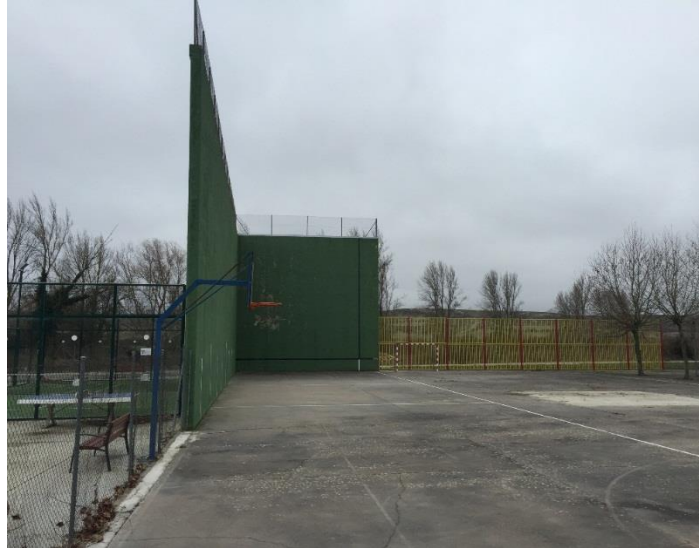
Vista del frontón desde el fondo norte de la pista de fútbol sala
